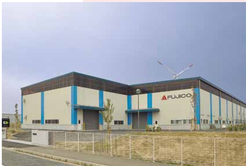
北九州市若松区に完成したフジコーの「若松響工場」
