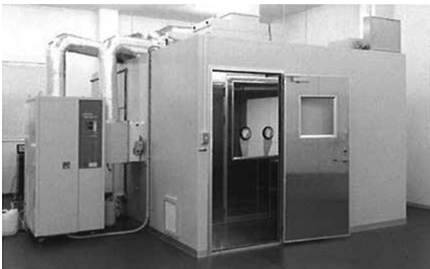
▲バイオ・クリーンルーム
