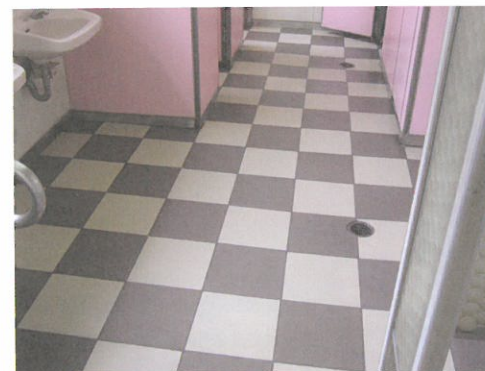
光触媒と溶射技術を使った MaSSC 技術で作られた内装用のタイル(右の写真3点)と、施工した様子(上の写真)。
