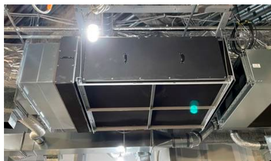
図1 除菌フィルターユニット FF6 装置外観
