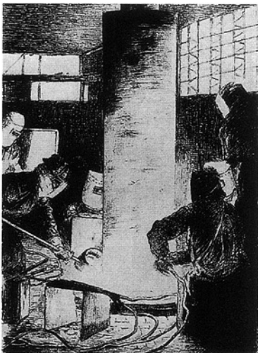
図-5 回転降下式銑掛け肉盛溶接作業
