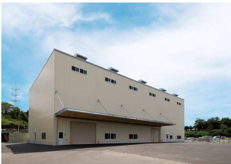
図 山陽工場の新棟全景
