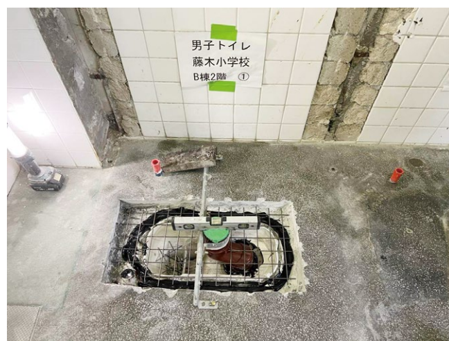
図 排水アジャスター施工の様子
